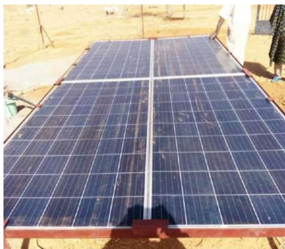
Image 4 : Installation des photovoltaïques
