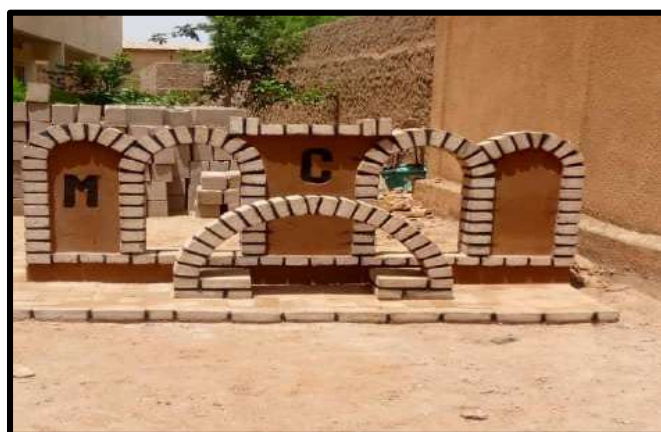
Maçonnerie mixte pour réalisation d'un ouvrage (parties en arc ou voûte).
